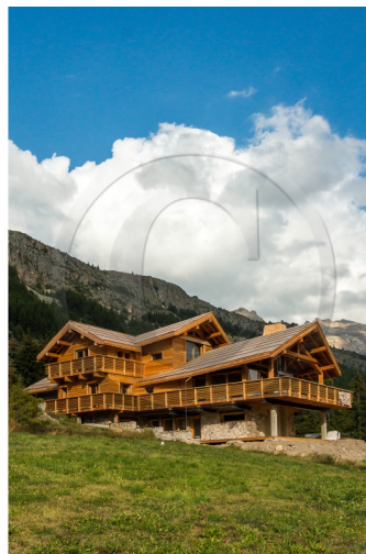
Hautes-Alpes (05), Briançon, charpente Robin Faure-Vincent // Hautes-Alpes (05), Briançon, charpente Robin Faure-Vincent
