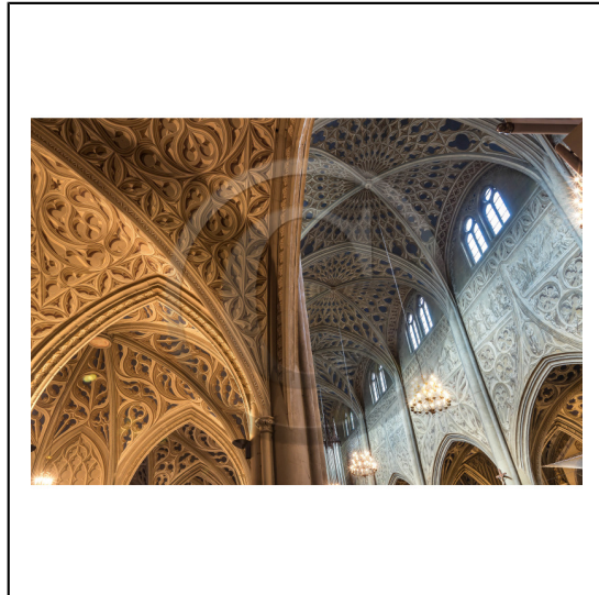
Savoie (73), Cité des ducs, Chambéry, préfecture de la Savoie, Cathédrale Saint-François-de-Sales de Chambéry, Peintures en trompe-l'œil // Savoie (73), City of the Dukes, Chambéry, Prefecture of Savoy, Saint-François-de-Sales cathedral of Chambéry, the largest ensemble of trompe l'œil painting in Europe
