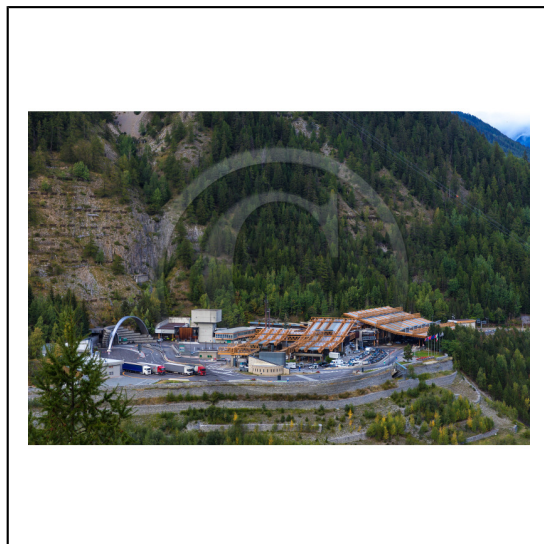
Italie, vallée d'Aoste, Courmayeur, Entrèves, Tunnel du Mont-Blanc // valley Aoste, Courmayeur, Entrèves, Tunnel du Mont-Blanc
