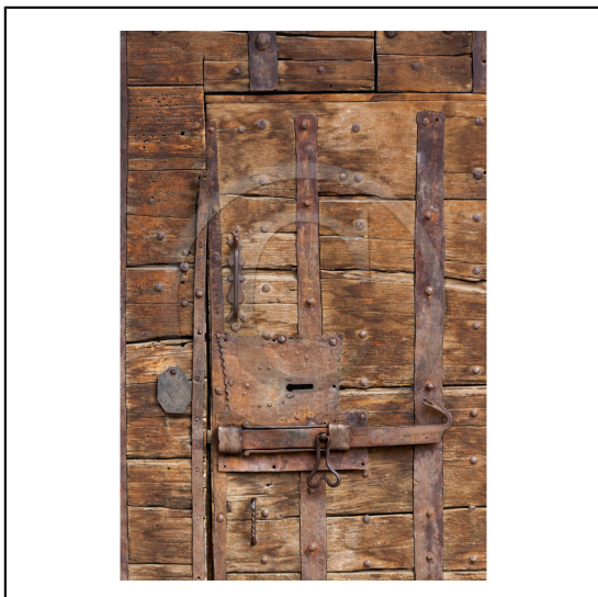
Hautes-Alpes (05), Vallouise, Les Vigneaux, Église Saint-Laurent classée monument historique, porte et vantaux, serrure en fer forgé, verrou terminé par une tête de chimère // Hautes-Alpes (05), Vallouise, Les Vigneaux, Église Saint-Laurent des Vigneaux
