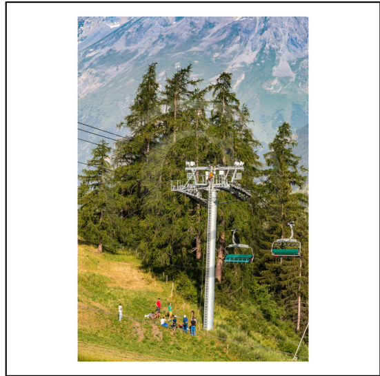
Savoie (73), Vanoise, Haute-Maurienne, Val Cenis, Lanslevillard, travaux sur pilone de remontée mécanique // Savoie (73), Vanoise, Haute-Maurienne, Val Cenis, Lanslevillard
